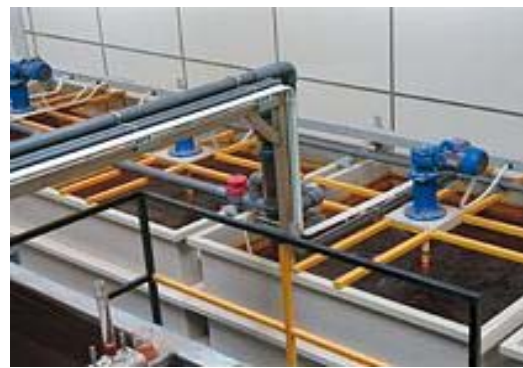
Figura 2. Instalación de tratamiento de aguas residuales industriales mediante un proceso avanzado de oxidación Fenton. Los reactivos requeridos en cada etapa son suministrados a los sucesivos reactores desde los depósitos en los que se almacenan en un proceso de tratamiento totalmente automatizado. La compacidad del sistema se favorece mediante el empleo de decantación lamelar. (Fuente: TECNA, s.l.r., Italia, www.tecna-italy.com )
