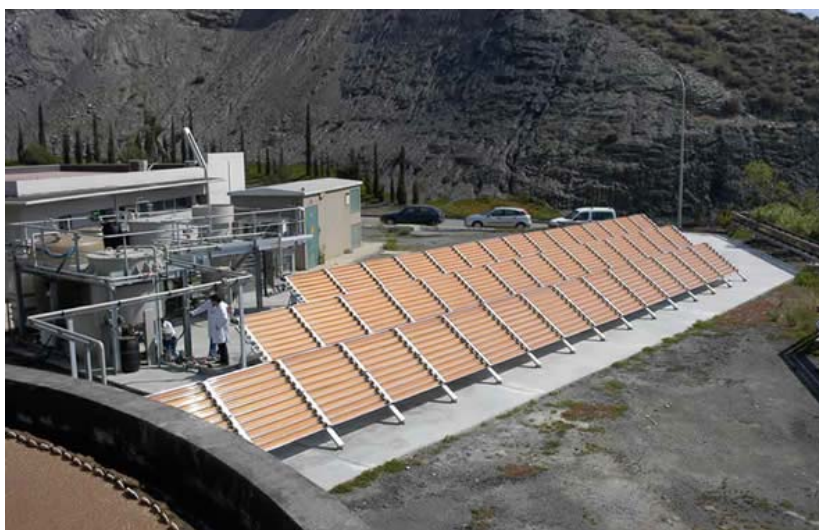
Figura 7. Instalaciones del tratamiento foto-Fenton solar de Albaida, S. L. en La Mojonera (Almería), destinadas al tratamiento de aguas de lavado con residuos de pesticidas. Obsérvese el tono rojizo causado por los precipitados de Fe(III) ( www.psa.es ).
