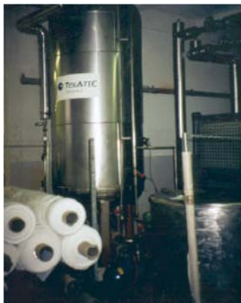
Figura 10. Reactor y esquema de tratamiento de caudales segregados de alta carga orgánica mediante oxidación catalítica Fenton en Schoeller Textiles AG (Suiza), operativo desde 1996 (Schömberger y Schäfer, 2003).
