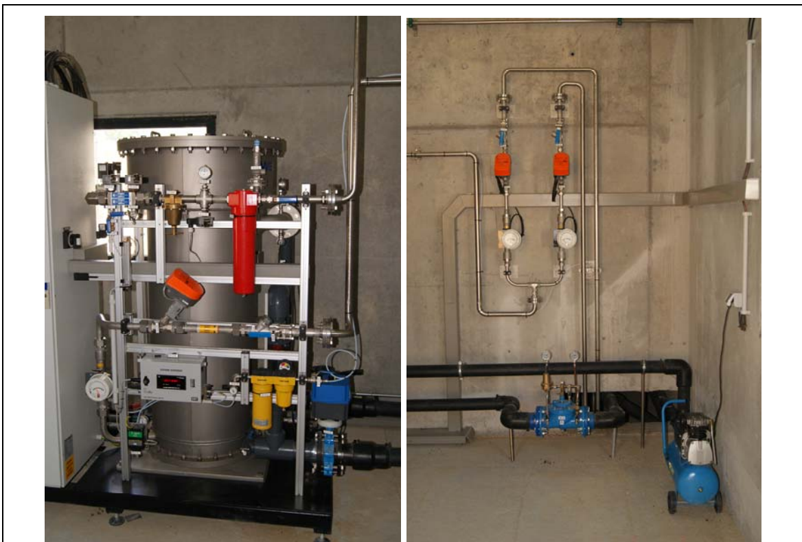
Figura 2.- Equipo de descarga para la generación de ozono in-situ ( izq. ) y conducciones con medidores de presión de gas ( der. ). ETAP-Lugo.
