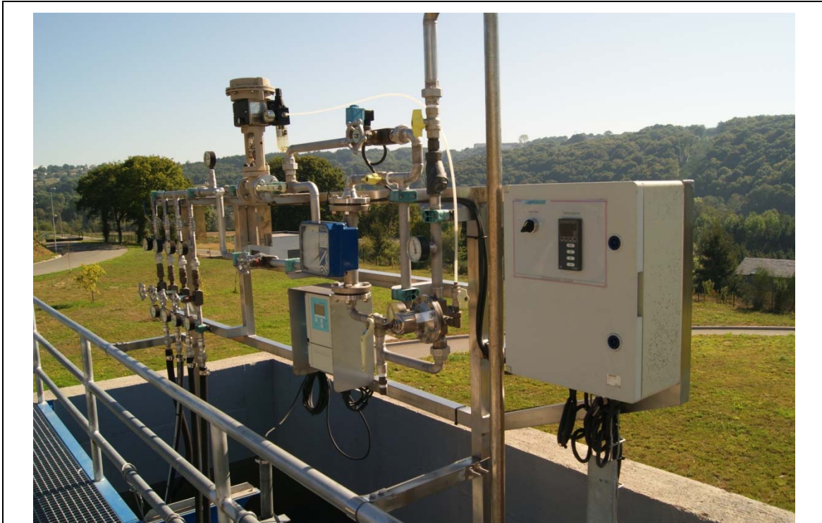
Figura 1. Sistema de regulación de pH (ETAP-Lugo)
