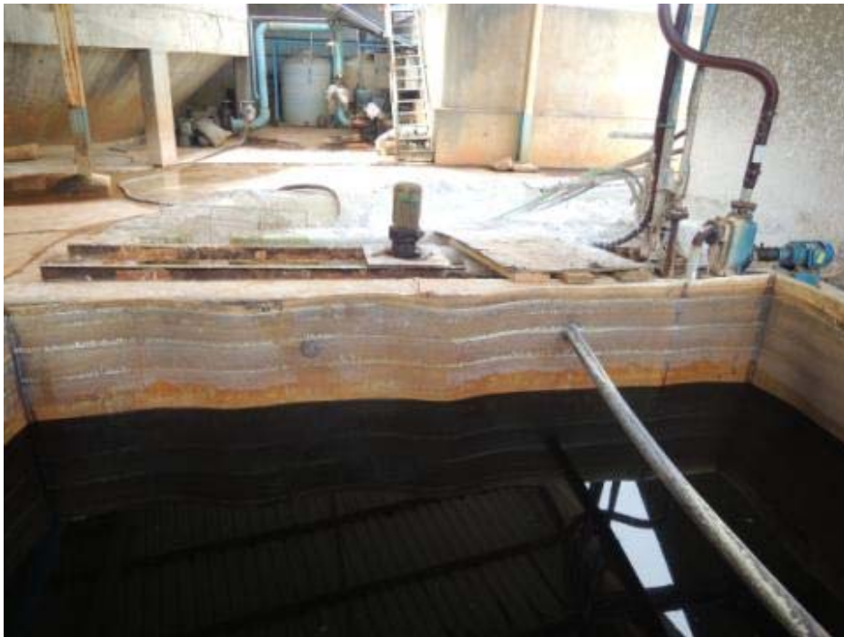
Figura 3. Sistema de corrección de pH en una ETP textil (Zhejiang Lifeng. 100 m 3 /h)
