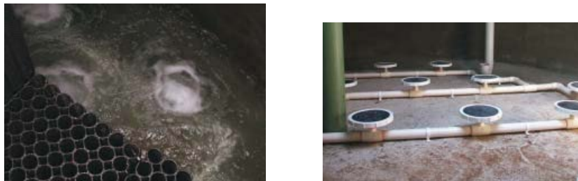
Figura 6.- A la izquierda un montaje con relleno tipo BIO-BLOK y se observa la aireación con burbuja gruesa. A la derecha, se observa el montaje de difusores.
