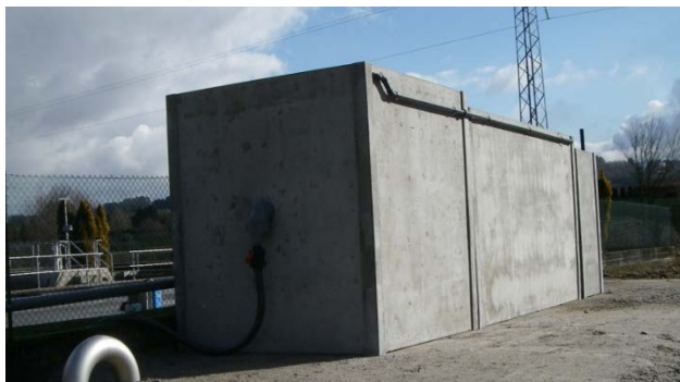
Figura 8.- Reactor de lecho aireable sumergido en hormigón prefabricado (LAS-NITRO). A la derecha, se observa el material de relleno colonizado (recubierto) por la biopelícula. (Foto: cortesía de INNDES, Ltd.)
