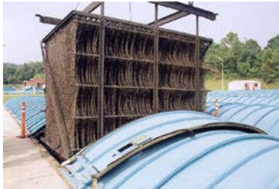
Figura 3.- Soporte fijo de cuerdas Ringleace. A la izda. limpio; a la dcha. colonizado por biopelícula.
