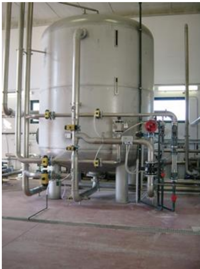
Figura 2.- Unidad de intercambio iónico en una sola columna (Europrogetti Recovery Water Technology www.europrogetti-italy.com )
