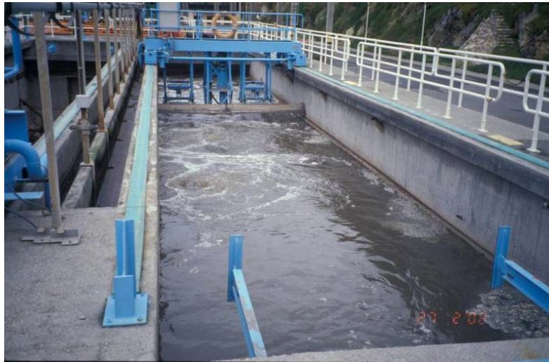
Figura 3 Canal de desarenador aireado.
