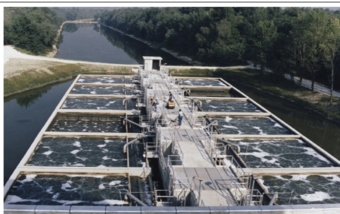
Figura 2 Sistema de biofiltros aireados de la tecnología Biofor
