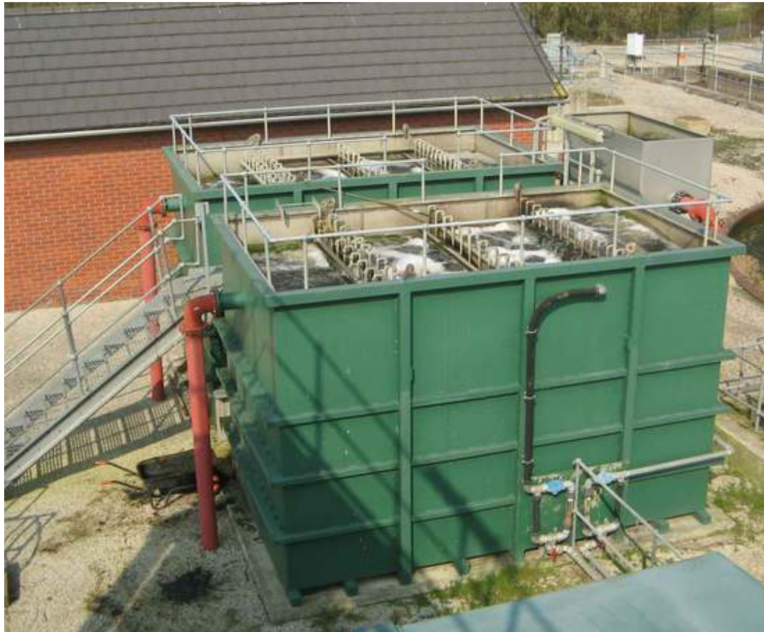
Figura 4 Sistema de biofiltros aireados prefabricado en estructura metálica para caudales de hasta 1000 m 3 /d.
