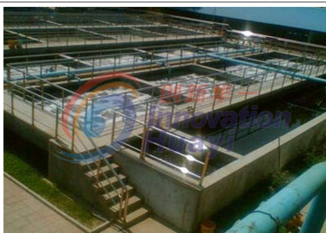
Figura 3 Sistema de biofiltros aireados de la tecnología Biocarbone
